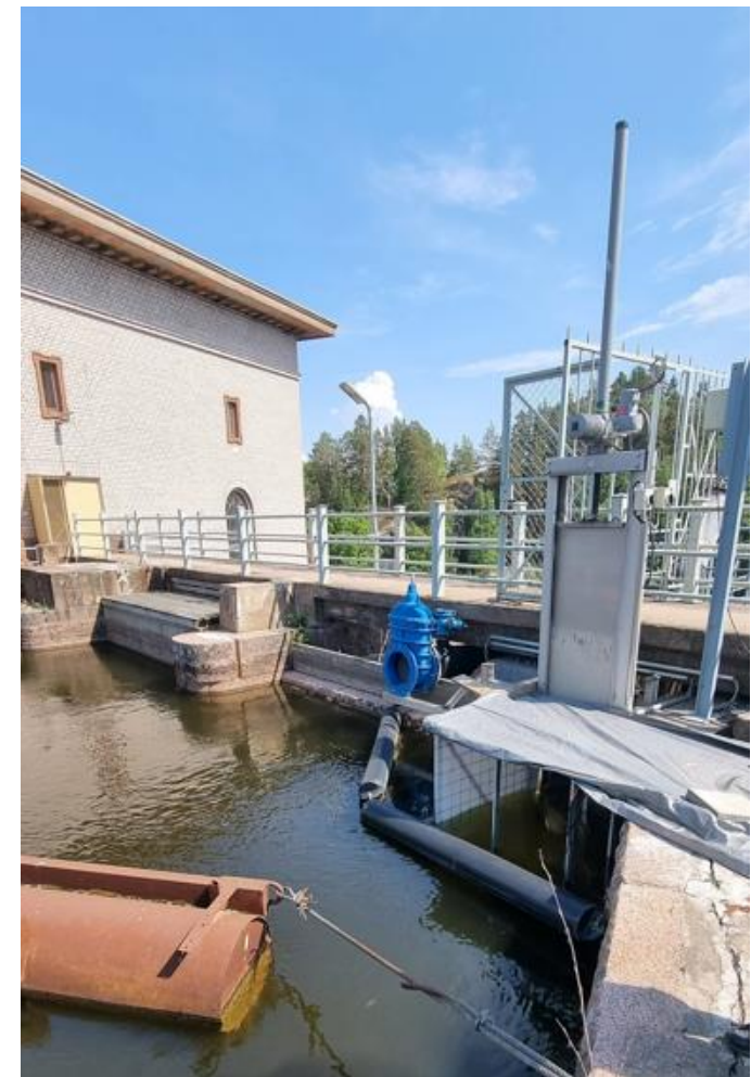
Kalatien suuaukko Korkeakosken voimalaitoksen yläaltaassa (kuva: Mika Marttunen)
